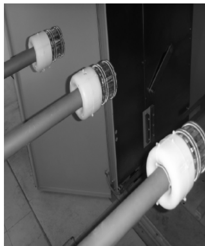
图4 气体存储及释放装置的现场安装
